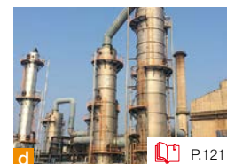
d 英国Carbon Clean Ltd.のCO 2 分離・回収技術を利用した設備
