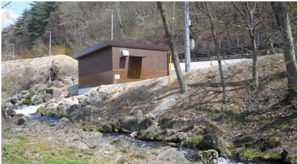
小水力発電所（山梨県北杜市）
