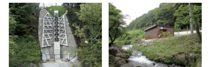
「地域に近い発電所を目指して」三峰川電力 小水力発電所(山梨県北杜市)
