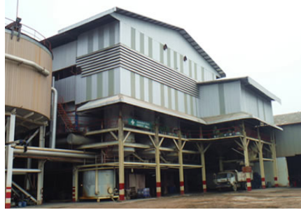
工場設備外観（一部）
