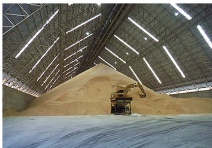
製品保管倉庫
