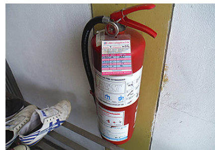
定期点検済みの消火器
