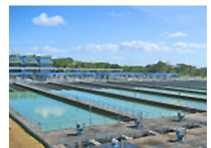
Maynilad社浄水処理場
