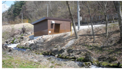
小水力発電所（山梨県北杜市）
