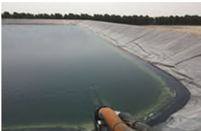
Lusail下水処理場・処理後の貯水池
