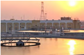
Doha West下水処理場
