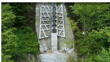
蓼科第四発電所（長野県茅野市）
