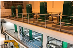
Lusail下水処理場・ポンプ場
