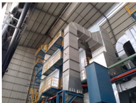
▲気泡型流動床ボイラ
