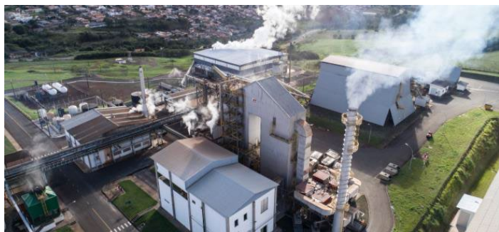
▲イグアスブラジル バイオマスボイラ
